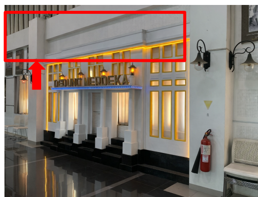
Gambar 7. Bagian area dinding yang bisa dimanfaatkan Sumber : (Dokumen Pribadi, 2025)
