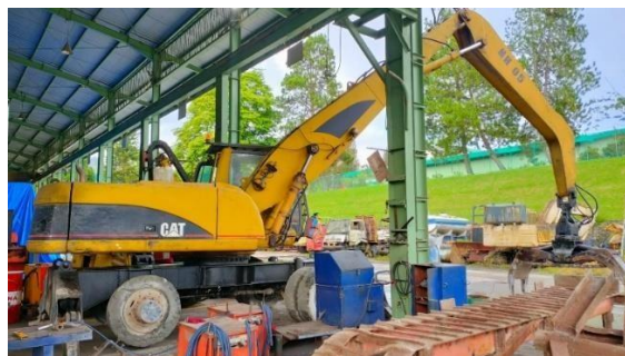
Gambar 1. Excavator Sedang Perbaikan
