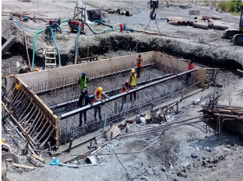
Gambar 13. Konstruksi Baja WF pada Pile Cap Sumber : (BPJN Provinsi Maluku, 2021)
