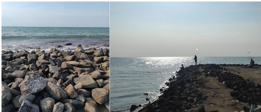
Gambar 14. Breakwater di Pantai Pondok Bali, Desa Mayangan
