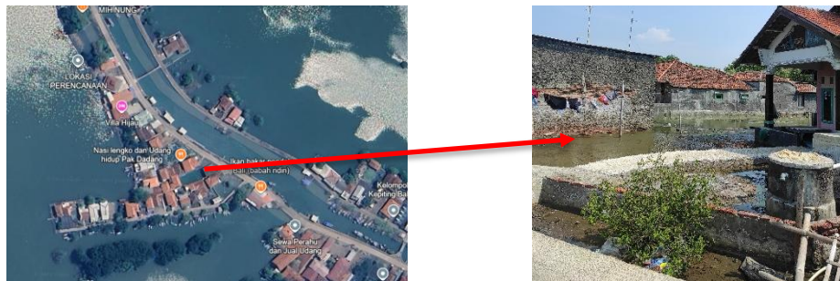
Gambar 13. Rumah Terbengkalai yang Terendam Air Laut di Desa Mayangan (Lokasi C)
