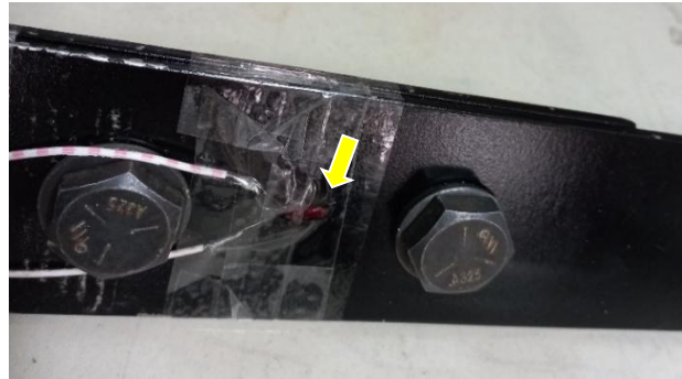
Gambar 8. Strain Gauge untuk Mengamati Pergeseran Antar Plat
