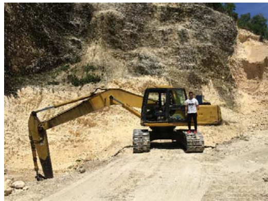
Gambar 2. Pengambilan Material di Lapangan Dibantu oleh Excavator
