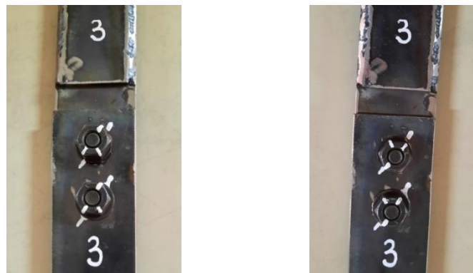
a. Penandaan ( Marking ) Posisi Snug Tight b. Tambahan \frac{1}{2} Putaran Mur
