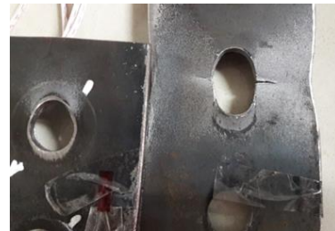
b. Kerusakan Lubang Baut
