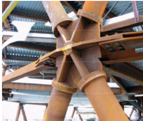
Gambar 2. Prefabricated Nodes pada Swiss Re Tower (Boake, 2014)
