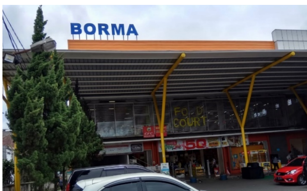
Gambar 1 Supermarket BORMA Dago Sumber: Powercat Jabar Area (2018)
